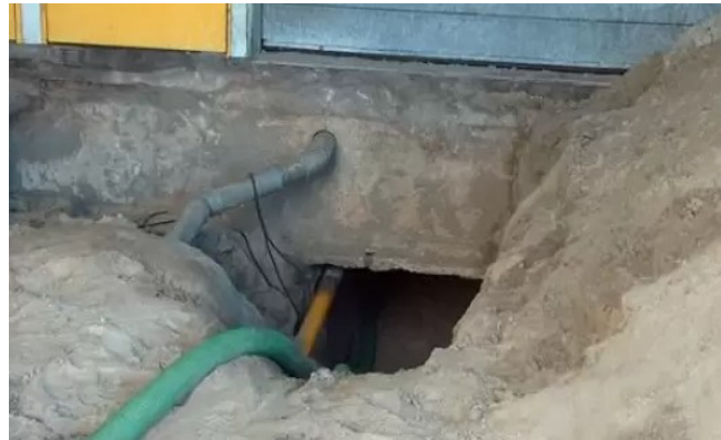
Luchtkanalen onder fundering
